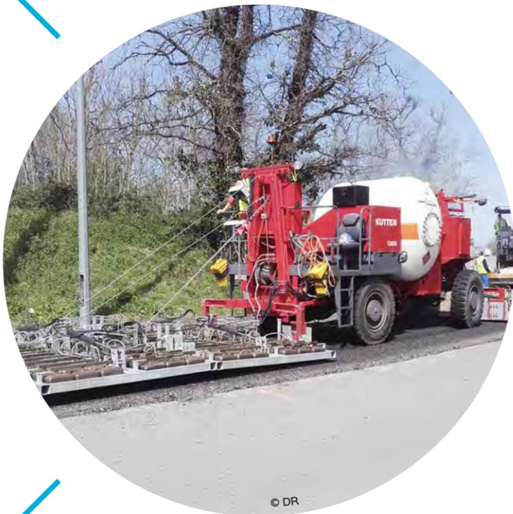
**GOUDRON.** L'entreprise toulousaine Malet a entamé début avril la seconde phase d'un chantier expérimental de recyclage de la chaussée. L'initiative doit permettre de prouver la résistance de routes fabriquées à partir de matériaux recyclés plusieurs fois.
